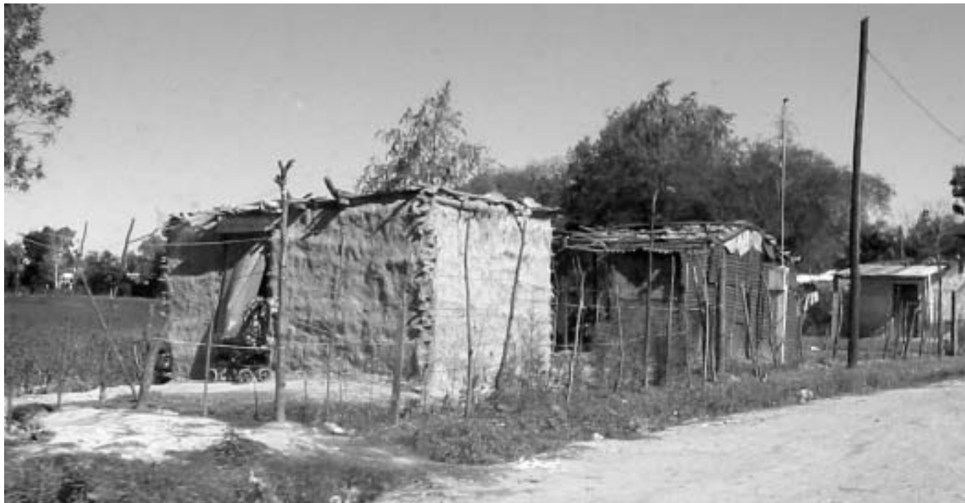
Viviendas de inmigrantes del campo a una ciudad del norte argentino. Fusión de tecnologías autóctonas degradadas con tecnología de la marginalidad urbana, en terrenos municipales a borde de laguna, declaradas de uso prohibido por inundabilidad periódica.
